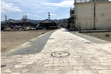
2024年の元旦に発生した能登半島の地震災害と、その夏に襲い掛かった豪雨の大災害の大きな爪痕です。現地では今年4月中旬に避難された住民の方は仮設住宅へ移転され、ようやく避難所が閉鎖されました。
